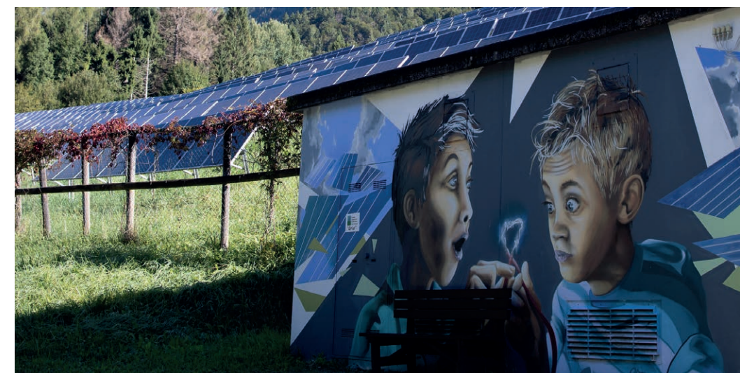
Realizzazione murales sulle facciate delle cabine in media tensione
