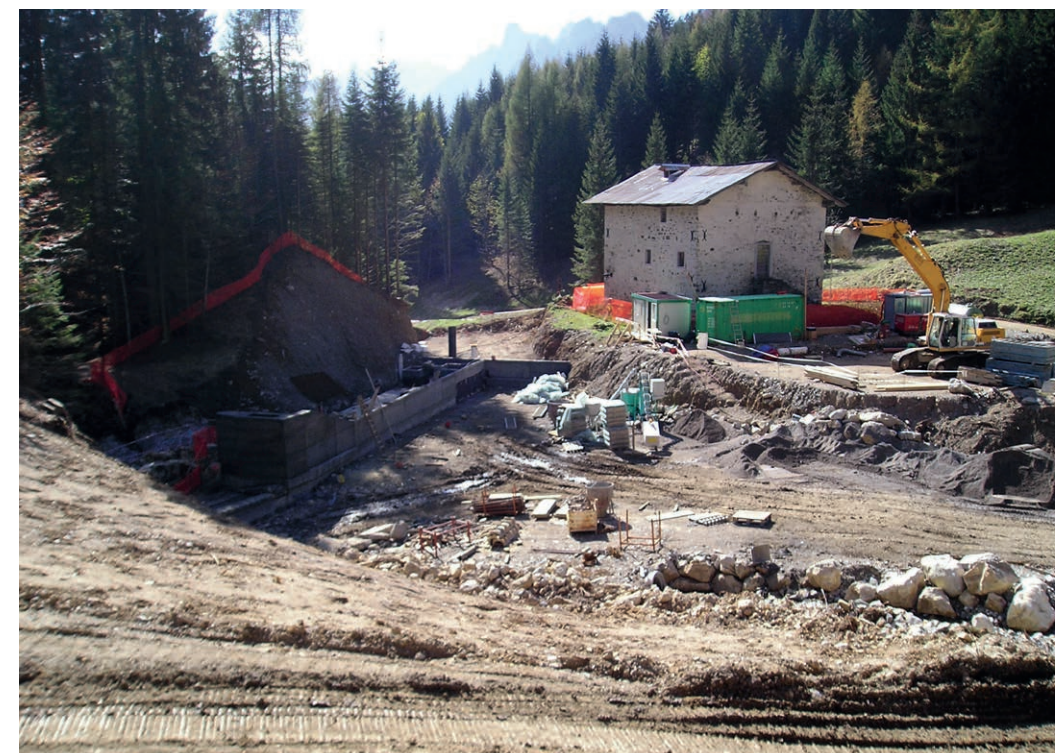
Cantiere centrale Tolina
